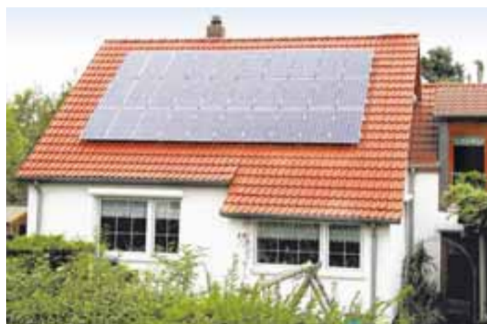
Egal, ob „Einspeiser“ oder „Selbstnutzer“, eine Fotovoltaikanlage lohnt sich immer.
